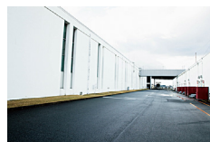
守山工場外観
